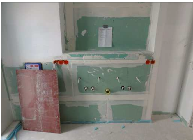
Versteckte Schimmelschäden befinden sich häufig hinter Vorwandinstallationen (links), die in nicht ausreichend getrockneten Innenräumen montiert wurden. Hier war ein vollständiger Rückbau erforderlich (rechts).
