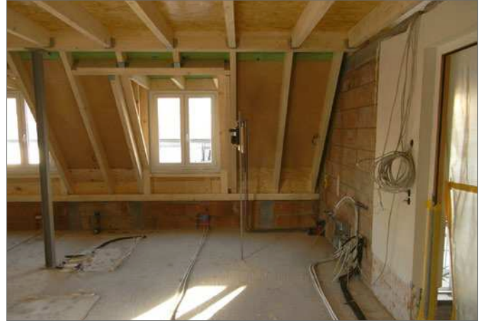
Deutlich sichtbare, schwarze Schimmelsporen im Dachgeschoss (links), aufgrund dessen die befallenen Bauteile entfernt und ersetzt werden mussten (rechts: nach der Sanierung).
