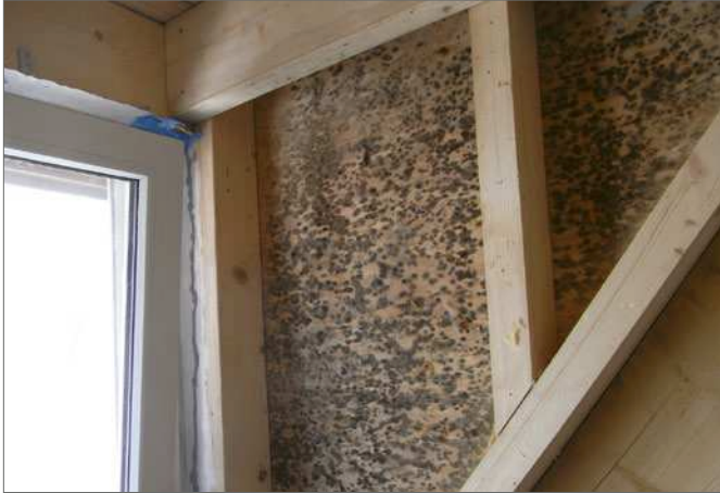
Deutlich sichtbare, schwarze Schimmelsporen im Dachgeschoss (links), aufgrund dessen die befallenen Bauteile entfernt und ersetzt werden mussten (rechts: nach der Sanierung).
