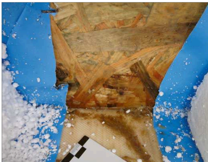
Feuchteschaden mit Schimmelbildung auf OSB-Platte aufgrund unsachgemäßer Sanierung
